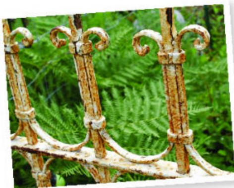
**Figura 3.4** Materiales metálicos de hierro (Fe) que están expuestos a la intemperie se oxidan con facilidad pues entra en contacto con el oxígeno ( $\text{O}_2$ ) y la humedad ( $\text{H}_2\text{O}$ ).
